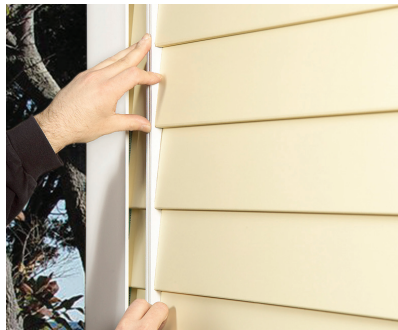
Étape 2 : (facultatif) Installer l'insert Snap-In pour Obtenir l'apparence du cèdre posé bout-à-bout.
